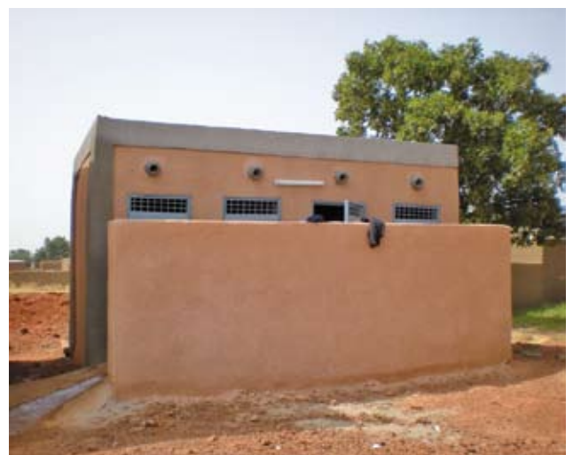
Les latrines neuves
