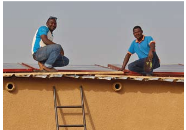
Installation des panneaux photovoltaïques.
