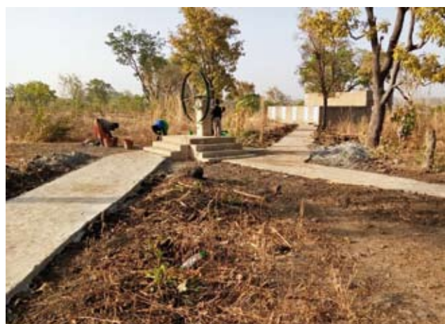
Les cheminements en direction du puits
