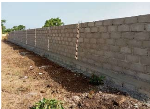
Une partie des 400 m de clôture
