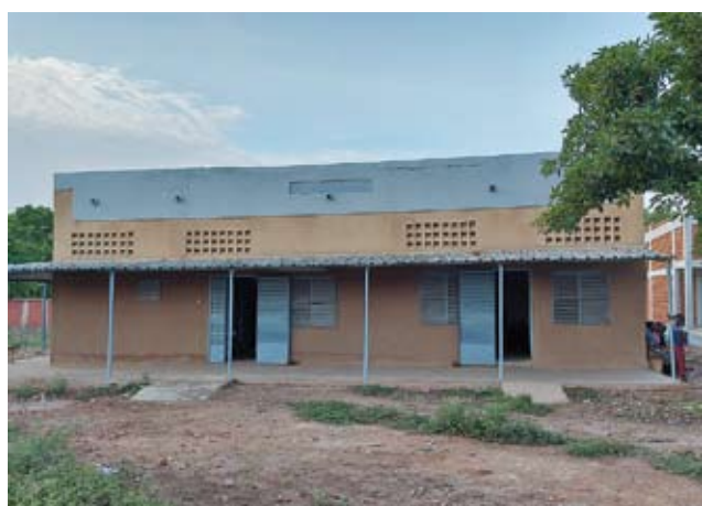
Bâtiment principal du centre rénové
